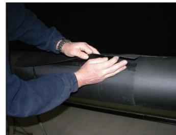
Установите лист на изолированный трубопровод таким образом, чтобы получить надлежащую адгезию между двумя частями шва.
