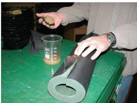
После прочного соединения шва теплоизоляционного материала нанесите двухкомпонентный клей на обработанную наждачной бумагой поверхность нахлеста...
