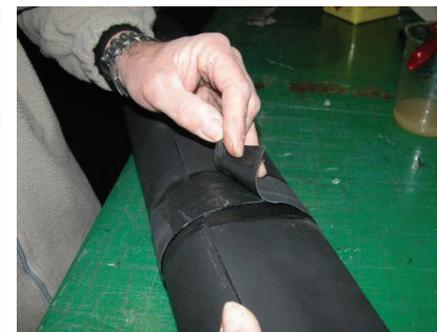
Закрепите ленту поверх стыка. Нахлест ленты на саму себя должен быть развернут «против воды»
