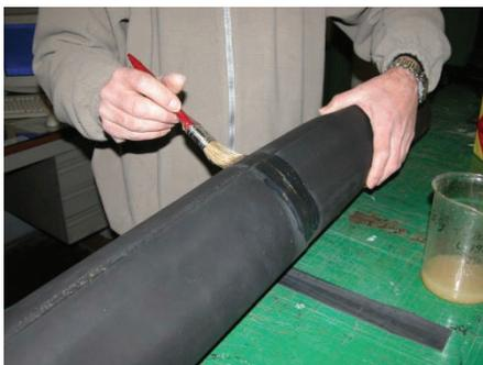
Нанесите двухкомпонентный клей на поверхность покрытия, обработанную наждачной бумагой.
