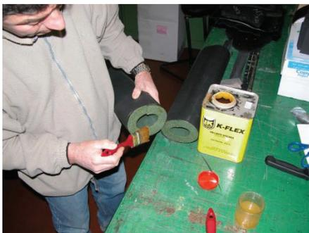
Нанесите клей K-FLEX или двухкомпонентный клей на торцы теплоизоляционных трубок.
