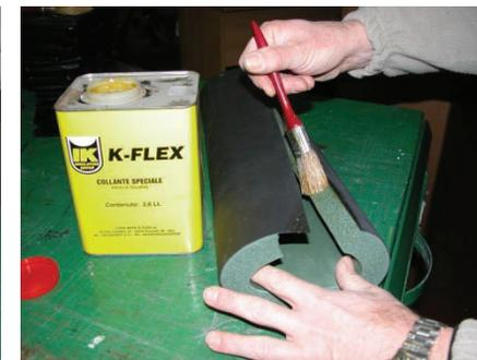
Нанесите клей K-FLEX на стороны шва теплоизоляционного материала.
