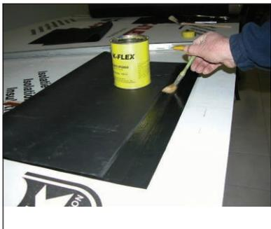
Нанесите двухкомпонентный клей на обработанную поверхность обратной стороны нахлеста.
