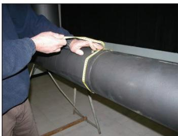
Измерьте длину окружности изолированного трубопровода
