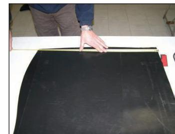
Разметьте прямоугольник с высотой, равной измеренной длине окружности с припуском 5 см и с длиной, равной длине секции трубопровода, подлежащего покрытию.
