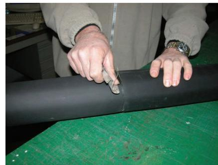
Обработайте наждачной бумагой поверхность покрытия возле шва.
