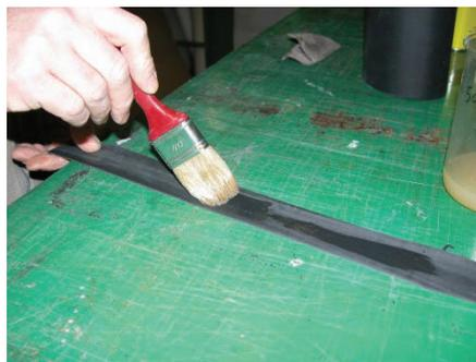
Нанесите двухкомпонентный клей на поверхность ленты, обработанную наждачной бумагой.
